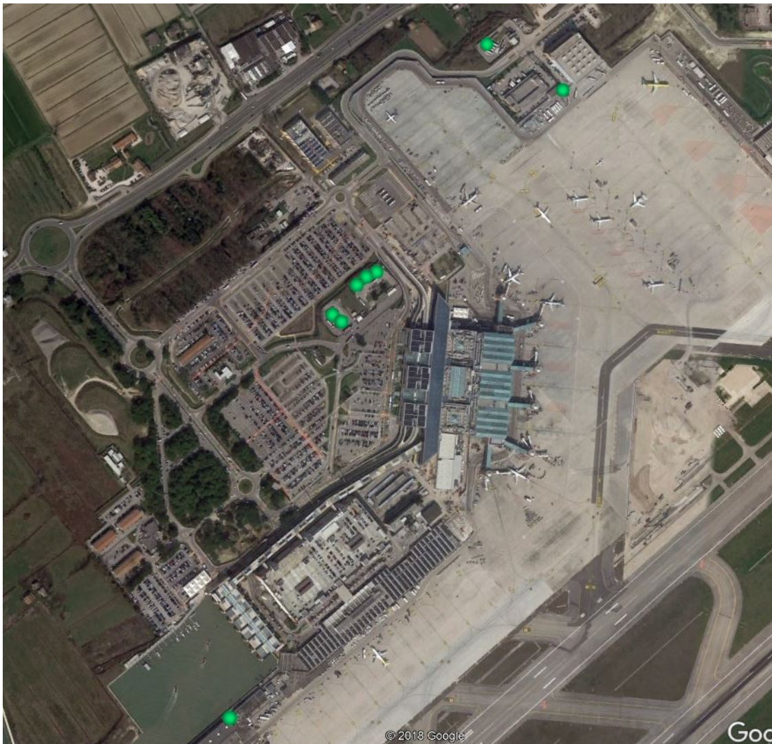
Figura 34. Dislocazione dei serbatoi
