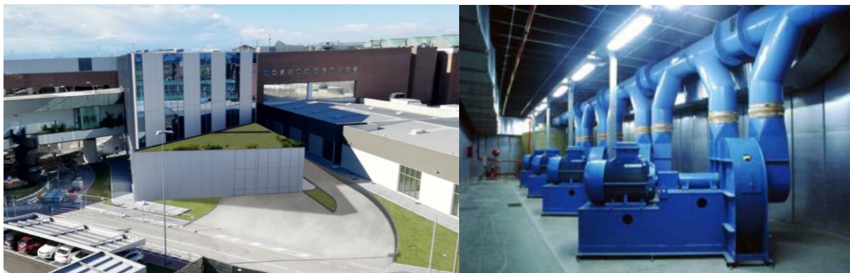
Esterno ed interno dell'impianto pilota di raccolta e trasporto pneumatico dei rifiuti
