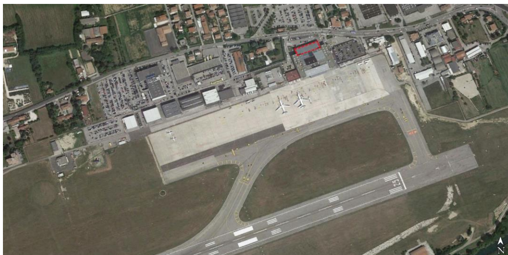
Intervento di Adeguamento Tecnico Terminal area LandSide
