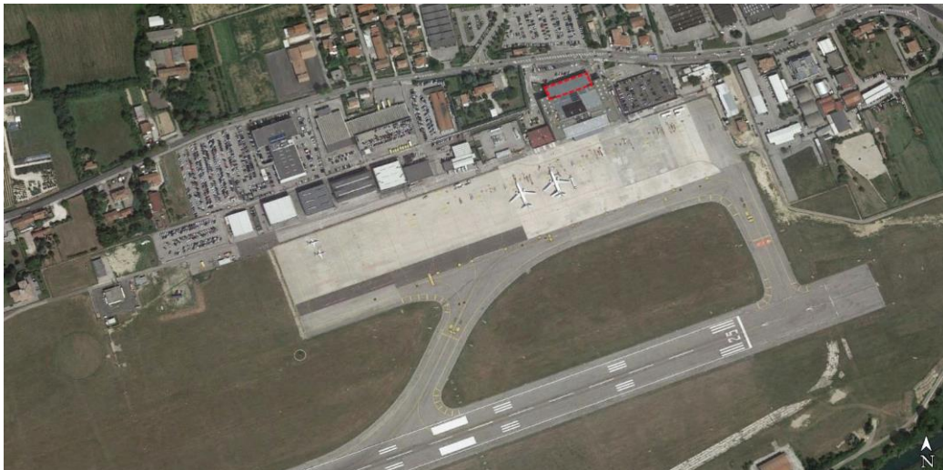
Intervento di Adeguamento Tecnico Terminal area LandSide
