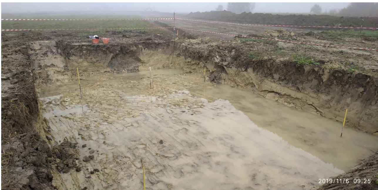
Foto 2. Scavo della sede di realizzazione dell'opera di restituzione del lato sud del bacino di espansione parzialmente allagata.
