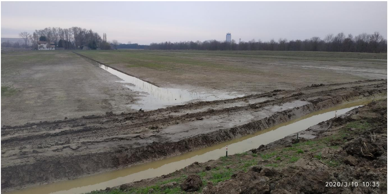
Foto 2 Scolina ancora isolata e non collegata al canale perimetrale collettore.
