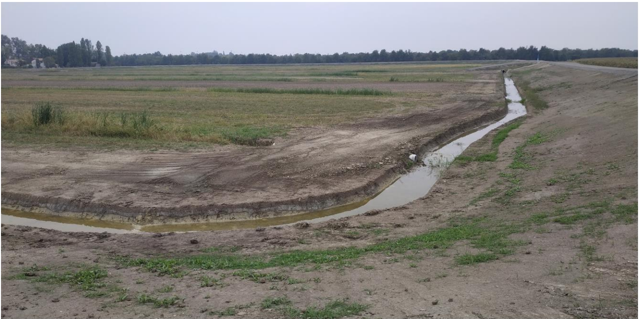
Foto 2 Il bacino di laminazione ultimato.
