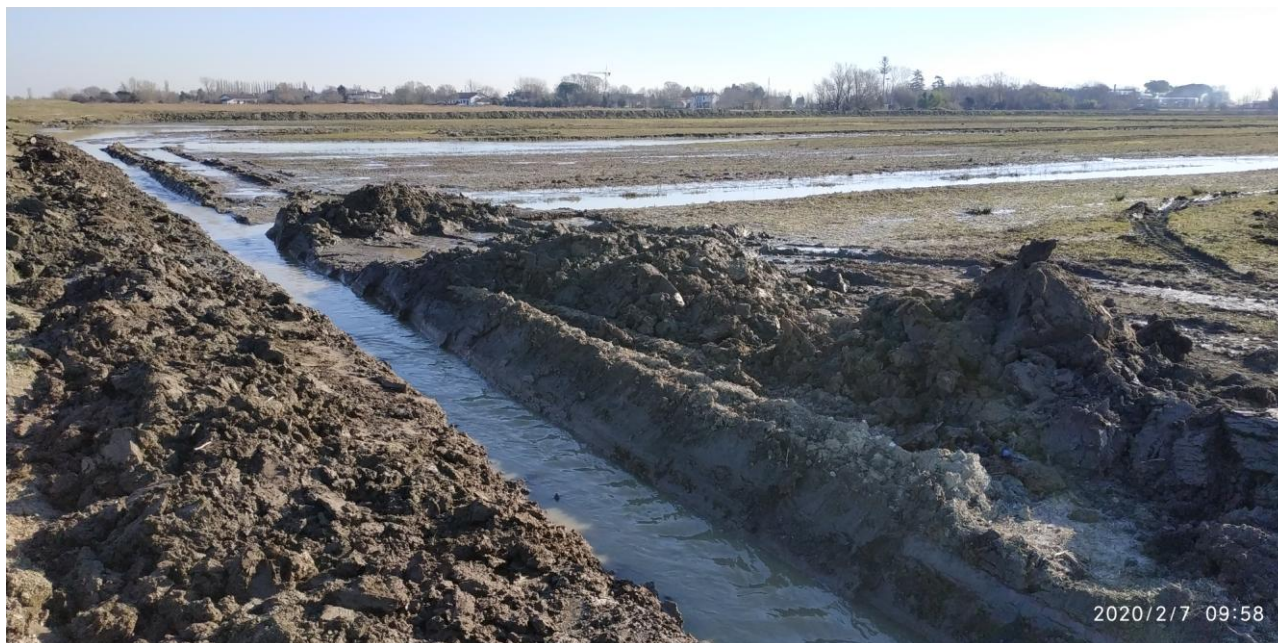
Foto 1 Drenaggio dei ristagni formati nel bacino di laminazione a causa delle forti precipitazioni di novembre.
