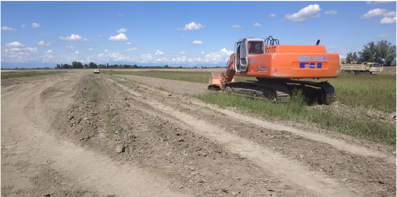
Foto 2 Scotico e adeguamento delle quote della porzione orientale del piano del bacino di laminazione.
