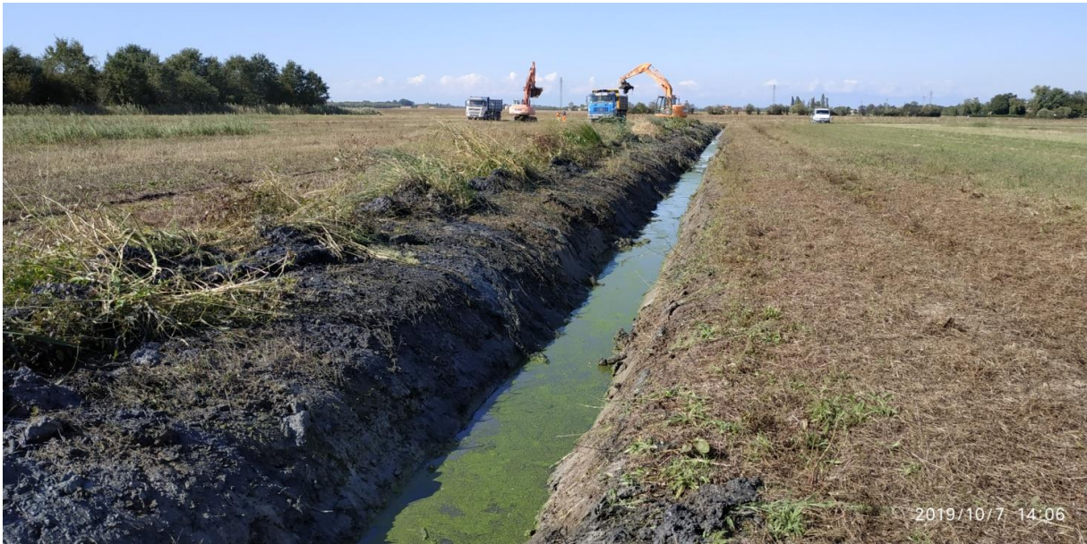
Figura 2-2 Il materiale scavato durante lo scotico, depositato a bordo scolina per consentirne l'ispezione, viene raccolto e caricato su camion dopo la verifica dell'assenza di esemplari di erpetofauna.
