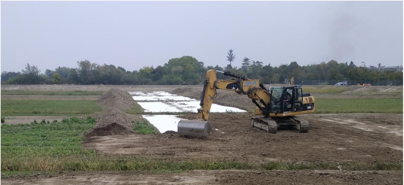
Foto 1 Fase di ricoprimento del geotessuto posato sulla sede della via Annia.
