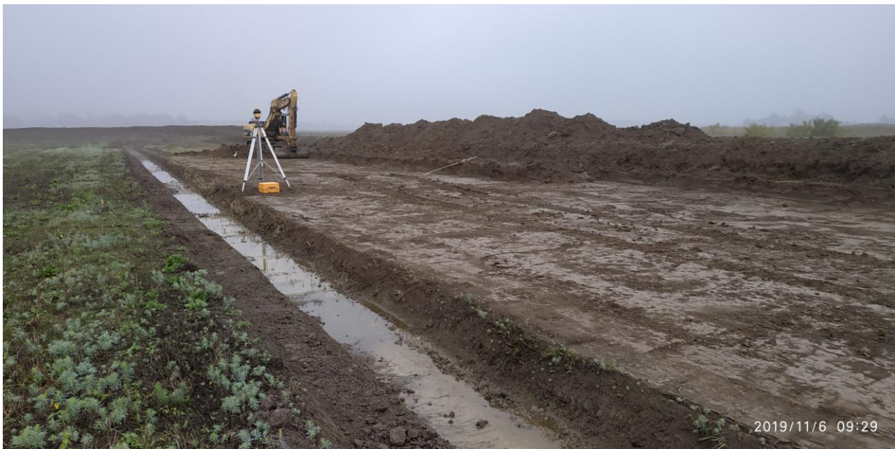
Foto 1 Attività di scotico e adeguamento del piano campagna alle quote di progetto tra la scolina n°10 e l'argine est del bacino di espansione.
