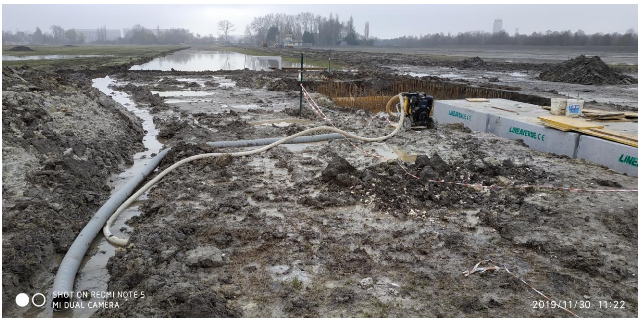
Foto 2. Lavorazione presso l'opera di restituzione del lato nord del bacino di espansione.
