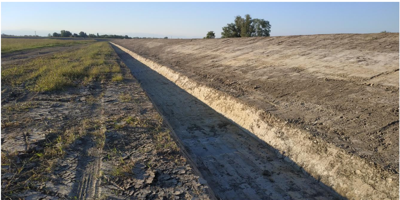
Foto 1 Completamento dello scavo e profilatura della scolina perimetrale al piede d'argine lungo il lato orientale del bacino.
