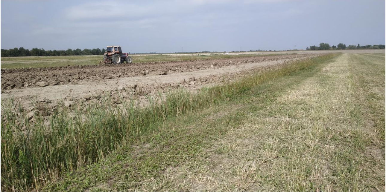
Foto 1 Sfalcio e sarchiatura delle superfici interne al bacino di laminazione ancora da sottoporre ad adeguamento alle quote di progetto.
