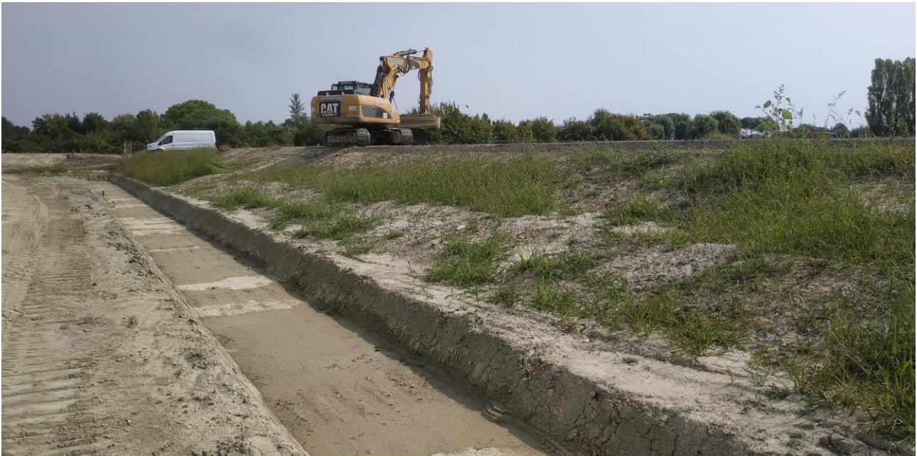
Foto 2 Sistemazione delle scarpate arginali e ultimazione della sottostante scolina perimetrale del lato sud del bacino.
