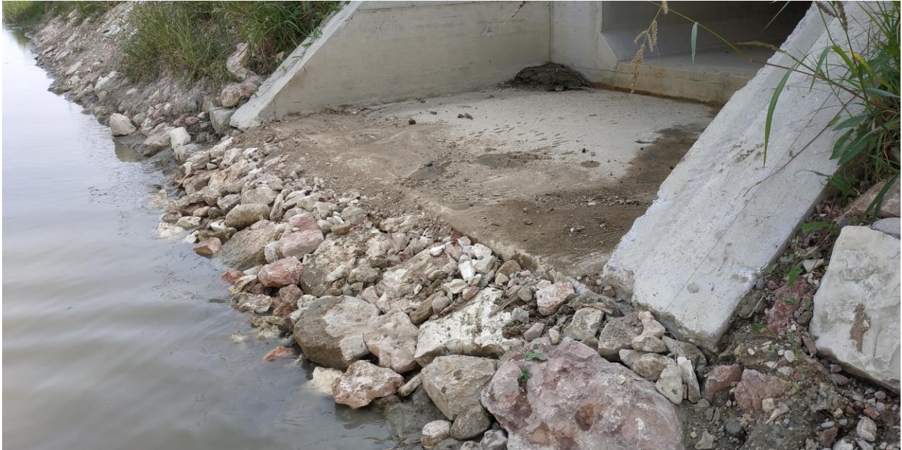
Foto 5 Lo scivolo è stato sagomato con pendenza di 30-40° senza modificare la sezione del canale.
