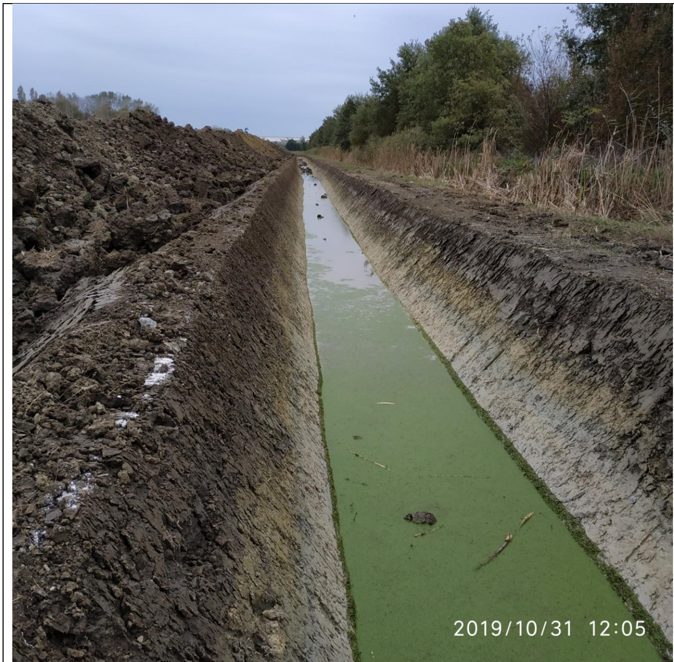
Foto 3. Nuovo canale di guardia nel tratto lungo il lato ovest del bacino di espansione.
