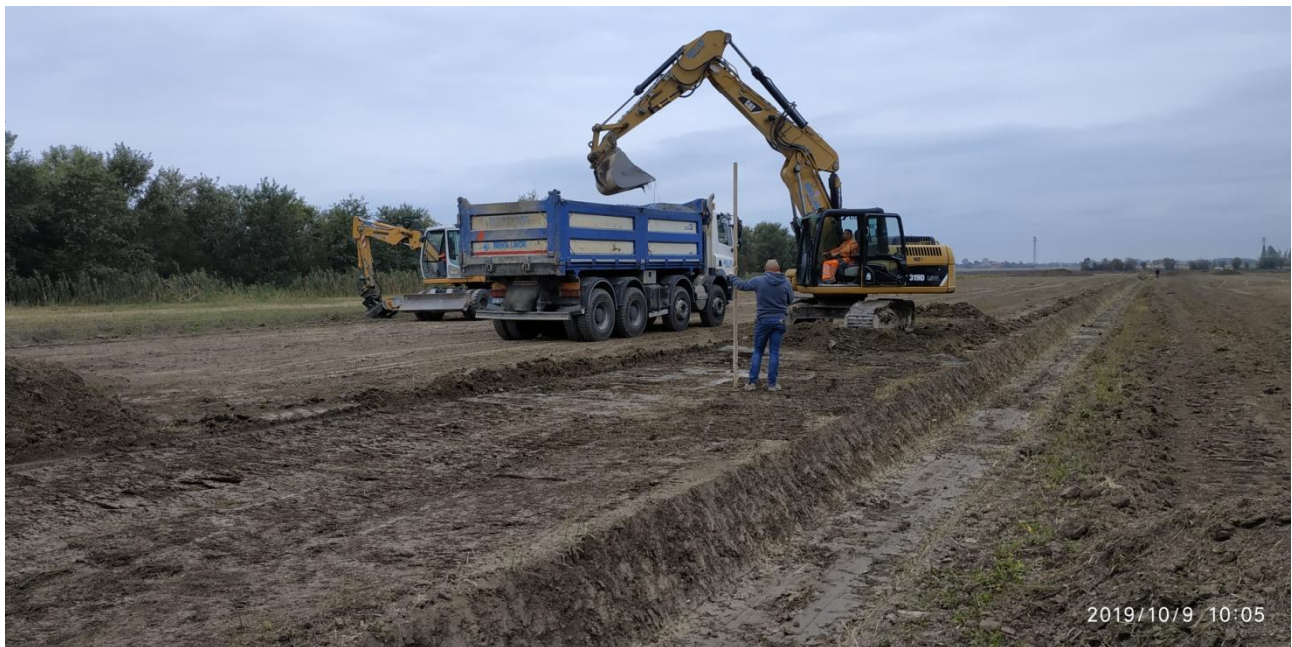
Foto 3 Avvio delle movimentazioni terra per l'adeguamento delle quote del piano campagna tra le scoline 1 e 2.
