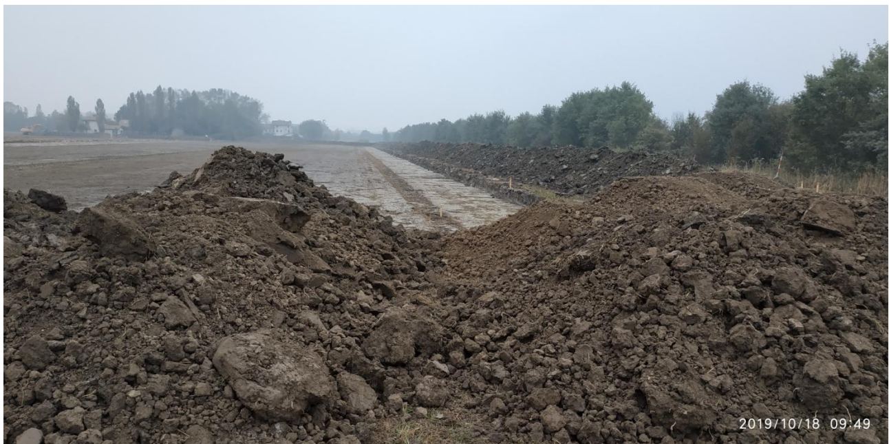
Foto 2 Riporto lungo la linea perimetrale dell'area destinata al bacino di espansione.
