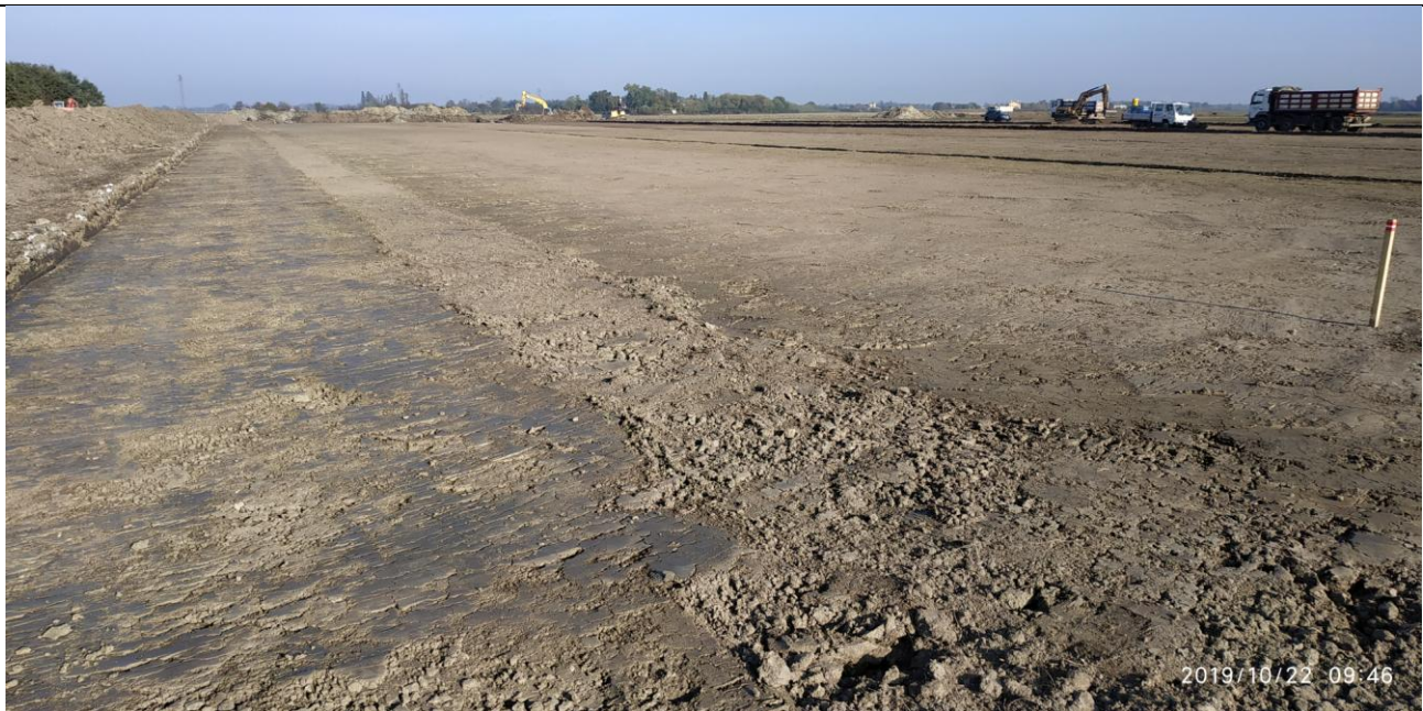
Foto 3 Ultimazione delle lavorazioni di adeguamento della quota del piano campagna tra le scoline n°1 (interrata in primo piano) e n°4.
