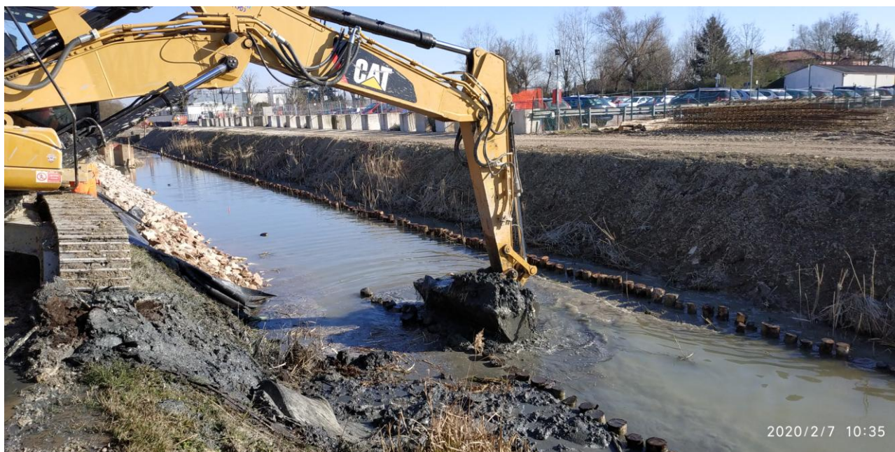
Foto 2 Scavo per il risezionamento e rivestimento di sponda del collettore Cattal.
