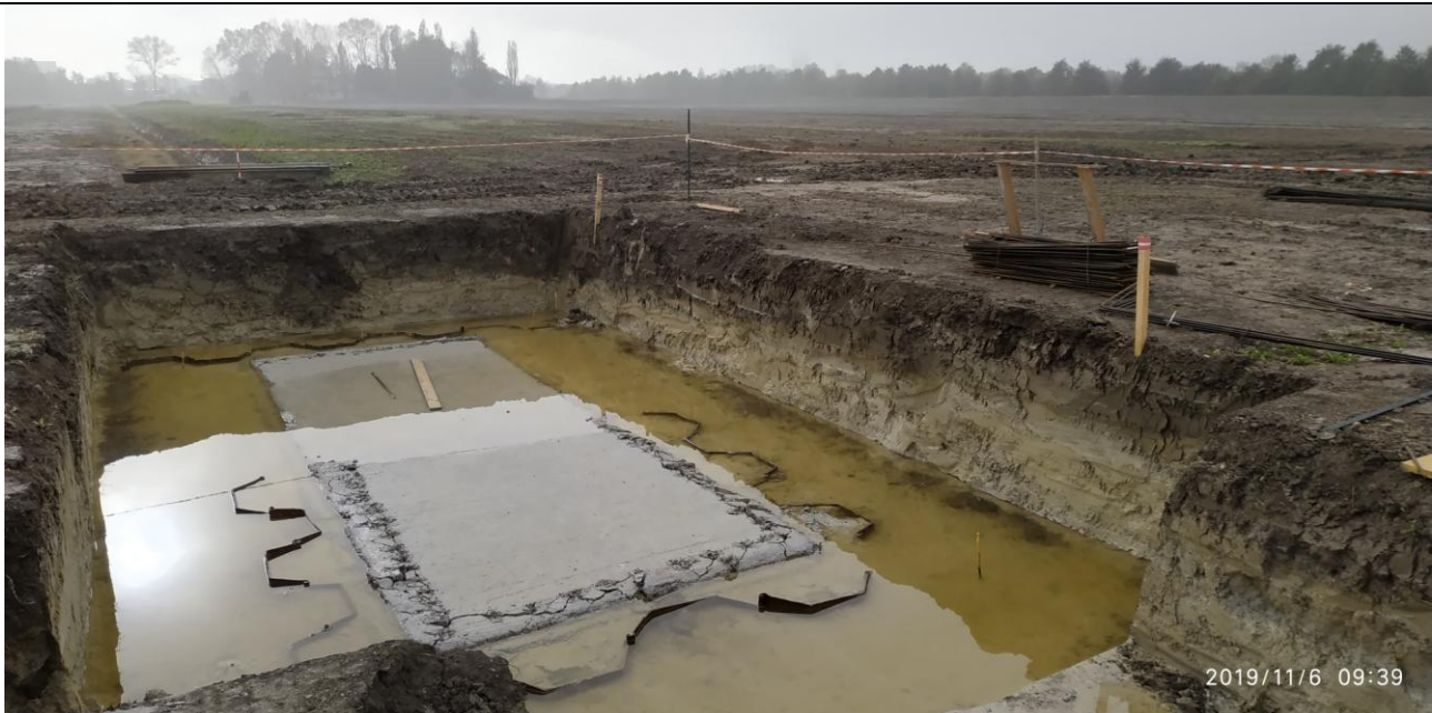
Foto 3. Sede dell'opera di restituzione del lato nord del bacino di espansione parzialmente allagata.
