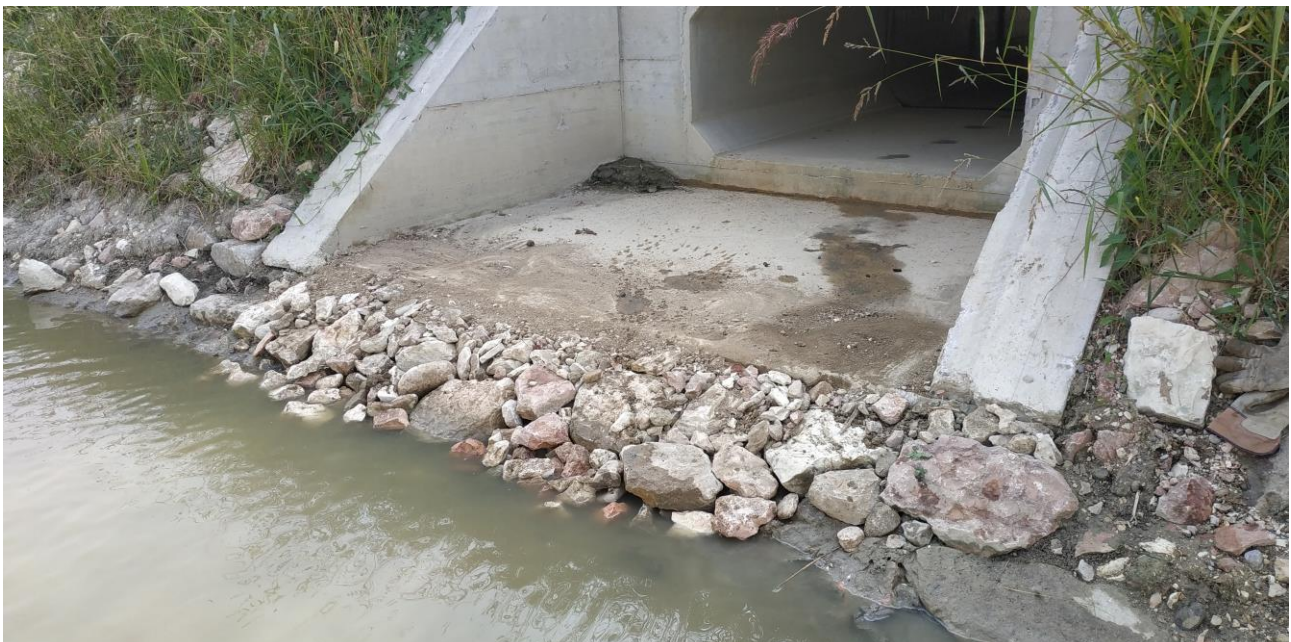
Foto 4 Creazione dello scivolo di raccordo tra pavimento e riva per facilitare lo spostamento della testuggine palustre all'interno del bacino di laminazione.
