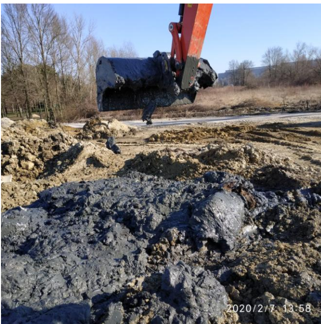
Foto 2 Deposito del fango di scavo del collettore Cattal per l'ispezione di verifica della presenza di eventuali esemplari di testuggine palustre.
