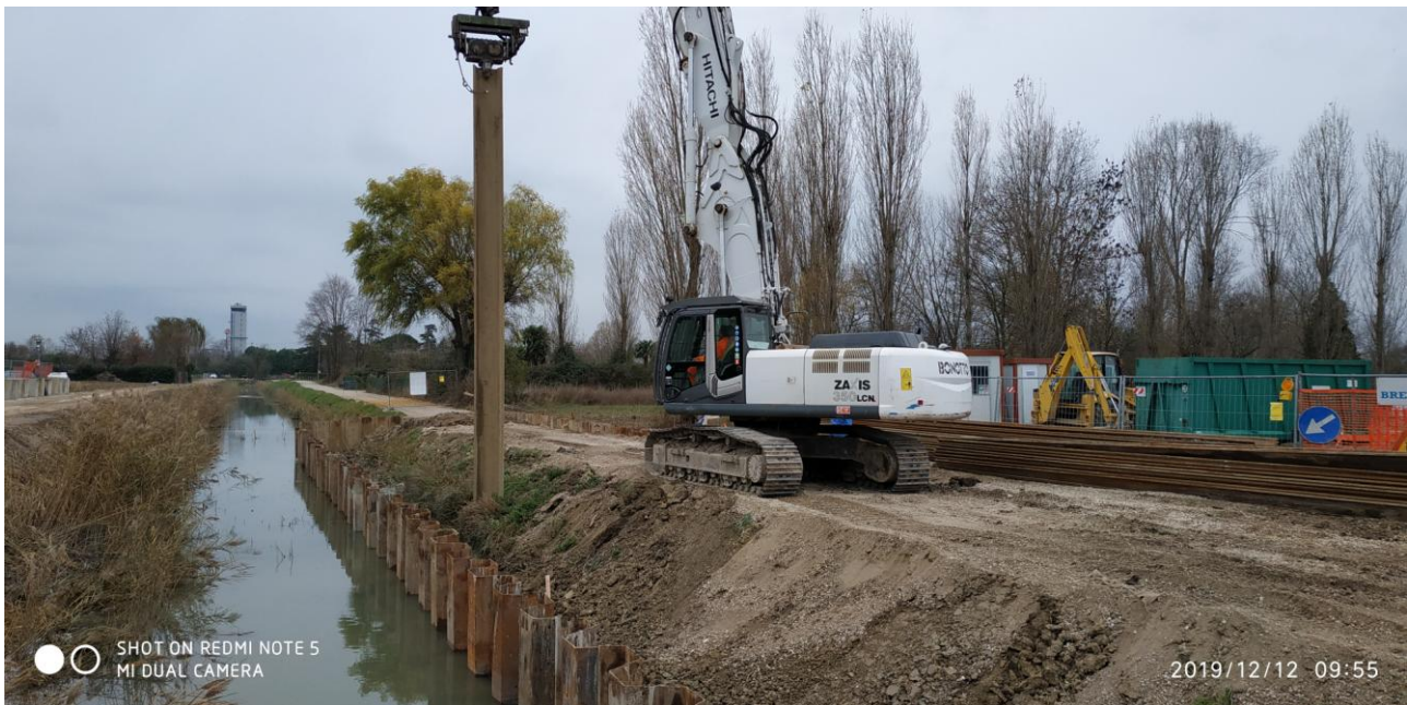
Foto 1 Infissione del palancoato per la realizzazione dell'opera di presa presso il collettore Cattal.
