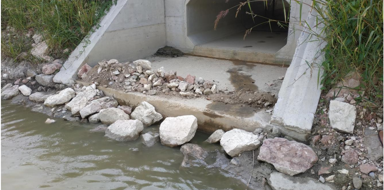
Foto 3 Stato di fatto dello scalino di raccordo tra pavimento dell'opera di presa e riva. Sul piano in calcestruzzo il brecciamme portato per la sistemazione.
