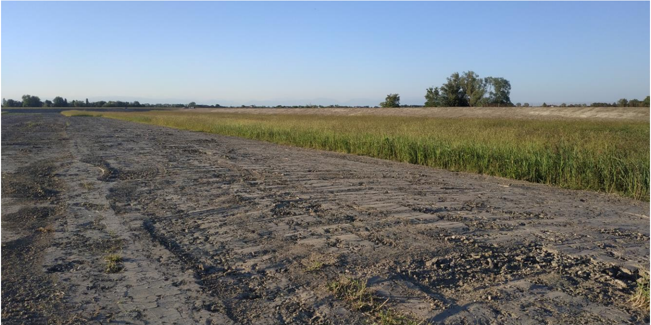
Foto 2 Avanzamento dello scotico e adeguamento delle quote della porzione orientale del piano del bacino di laminazione.
