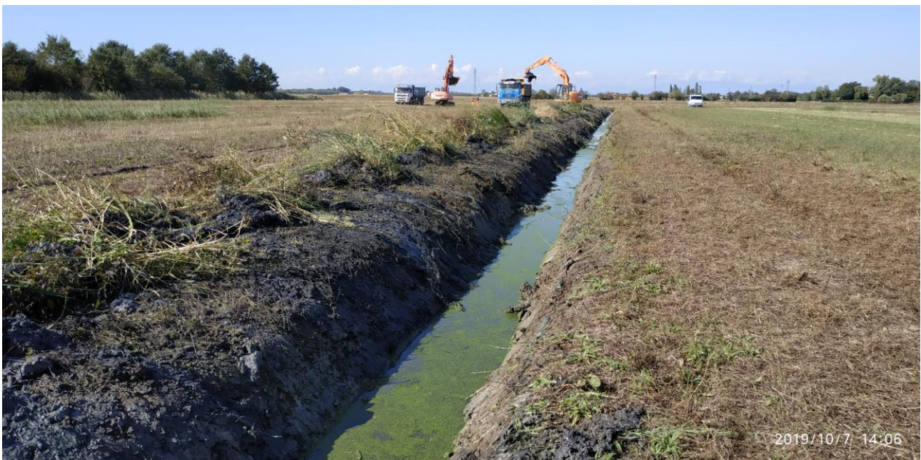
Foto 2 Il materiale scavato, depositato a bordo scolina per consentirne l'ispezione, viene raccolto e caricato su camion dopo la verifica dell'assenza di esemplari di erpetofauna.
