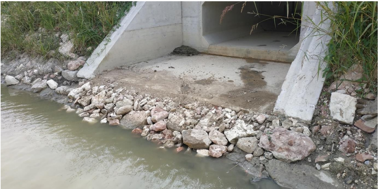
Figura 2-9 Creazione dello scivolo di raccordo tra pavimento e riva per facilitare lo spostamento della testuggine palustre all'interno del bacino di laminazione.
