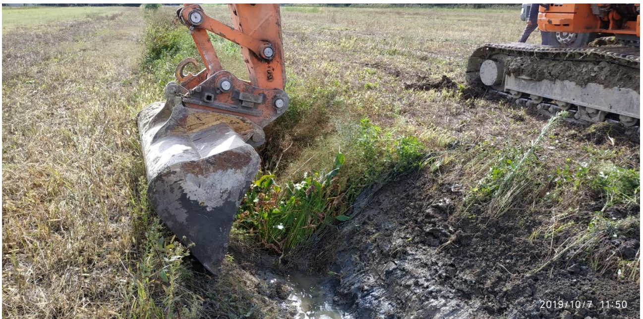
Figura 2-1 Scotico preventivo della scolina con presenza d'acqua, prima di procedere al risezionamento.
