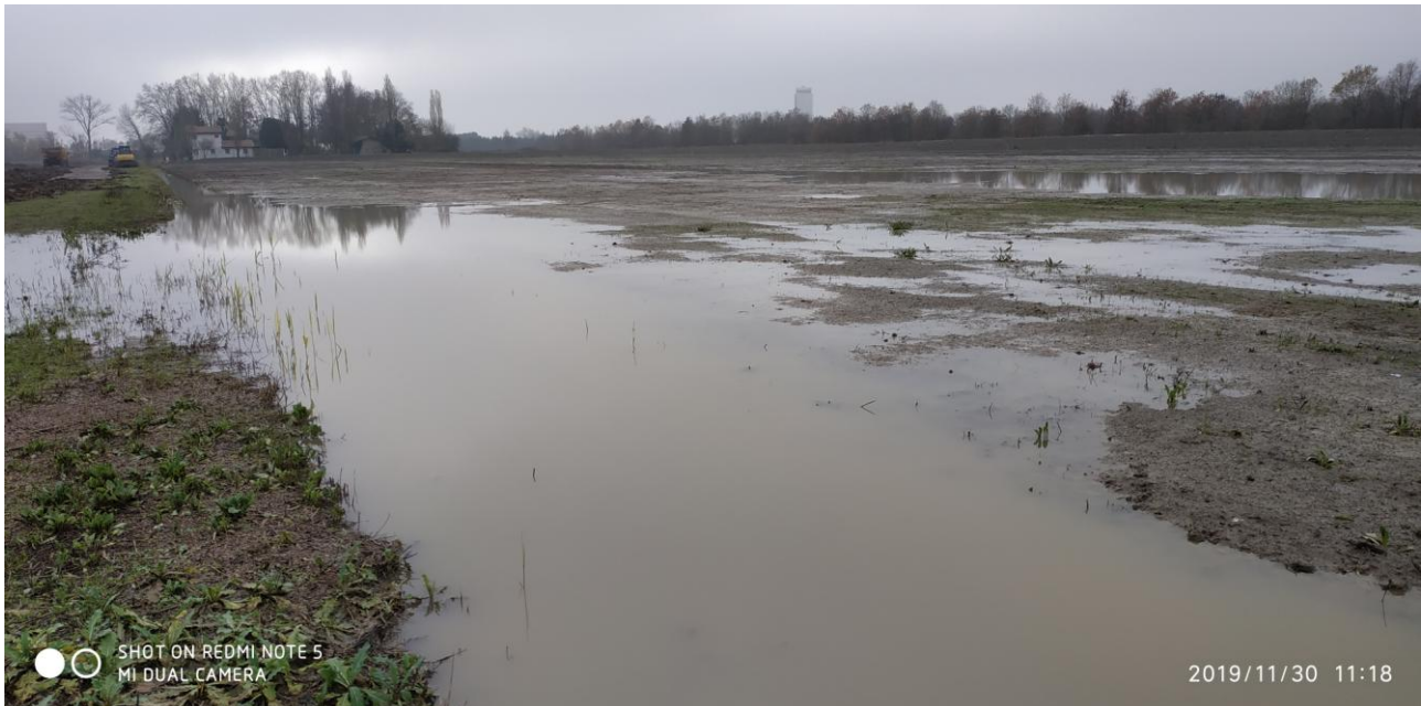
Foto 1 Ristagni e allagamenti nella porzione occidentale dell'area di bacino di espansione.
