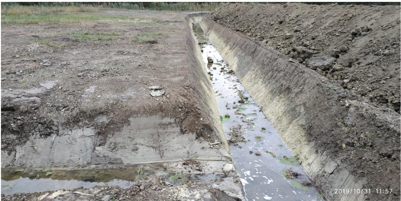
Foto 2. Innesto della scolina n°3 (a sx) nel canale di guardia lungo il lato sud del bacino.
