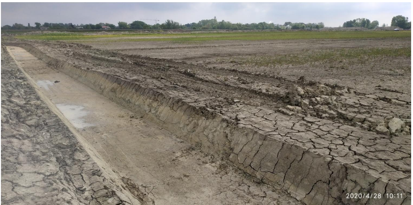
Foto 2 Canale perimetrale al piede dell'argine del bacino in asciutta.
