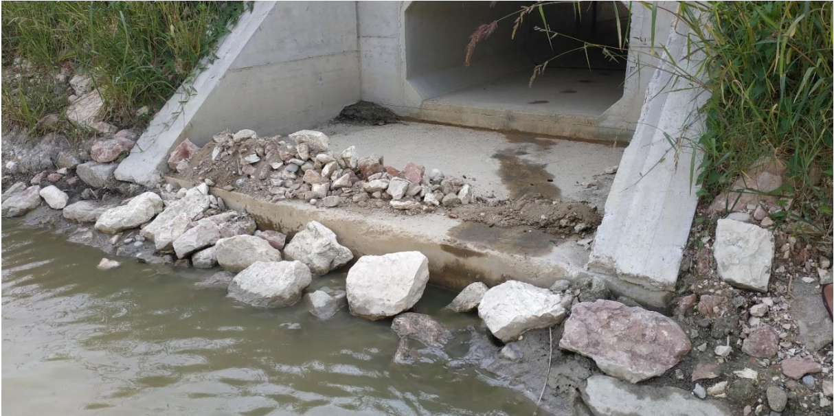
Figura 2-8 Stato di fatto dello scalino di raccordo tra pavimento dell'opera di presa e riva. Sul piano in calcestruzzo il brecciamme portato il 10/09 per la sistemazione.
