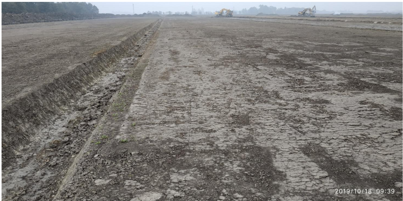
Foto 1 Ultimazione delle lavorazioni di adeguamento della quota del piano campagna tra le scoline n°1 e n°3.
