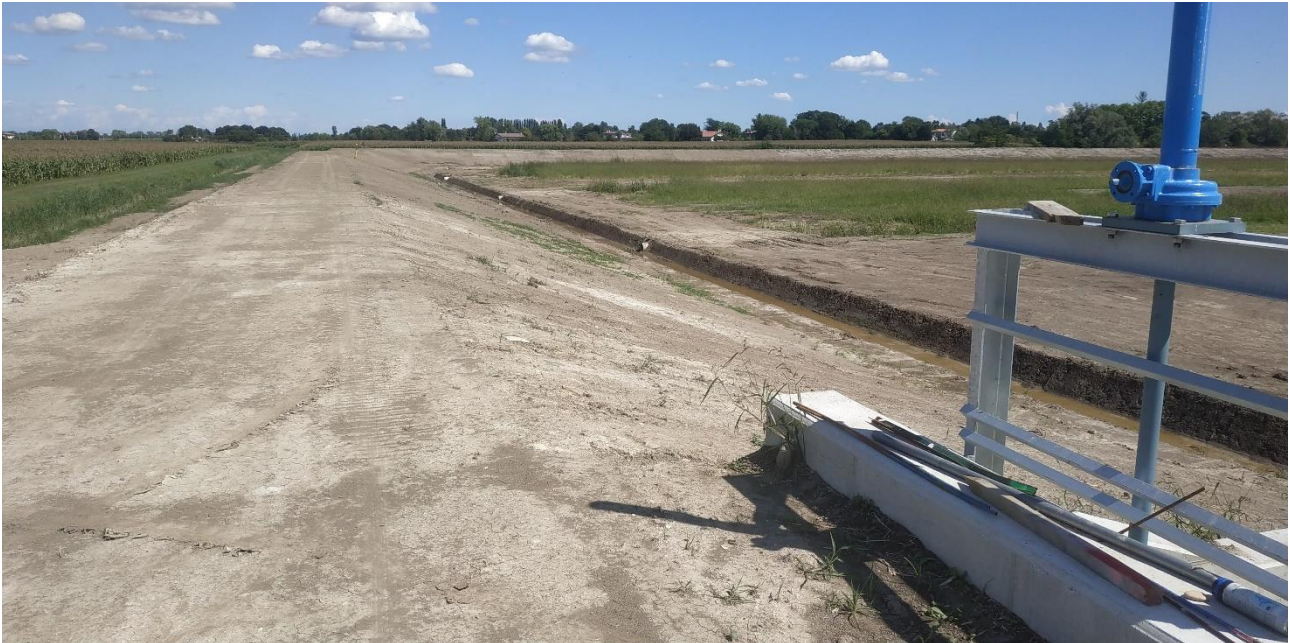
Foto 1 Argine del bacino con scarpate finite e chiavica dell'opera di restituzione. Si osserva la scolina perimetrale a piede d'argine con la messa in opera dei tombotti di raccordo delle scoline.
