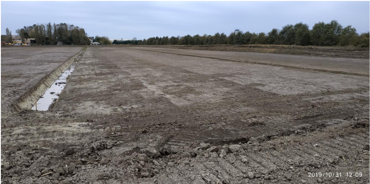
Foto 1 Bacino di espansione fotografato dal rilevato arginale nord. Le scoline sono attualmente isolate e scollegate dal canale irriguo ricevente.
