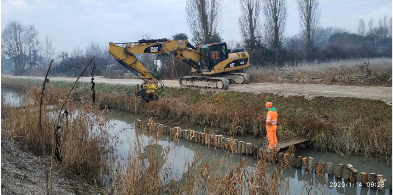
Foto 2 Impianto dei pali per la costituzione della protezione al piede arginale lungo la riva sinistra del collettore Cattal.
