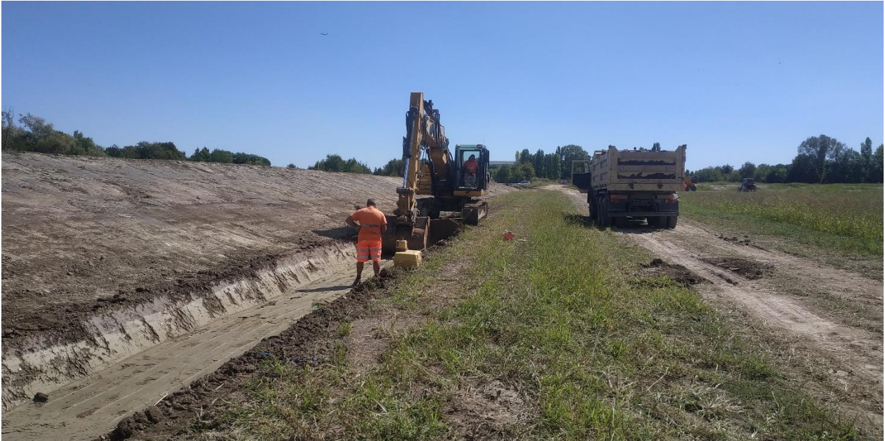
Foto 3 Scavo e profilatura della scolina perimetrale lungo il lato orientale del bacino.
