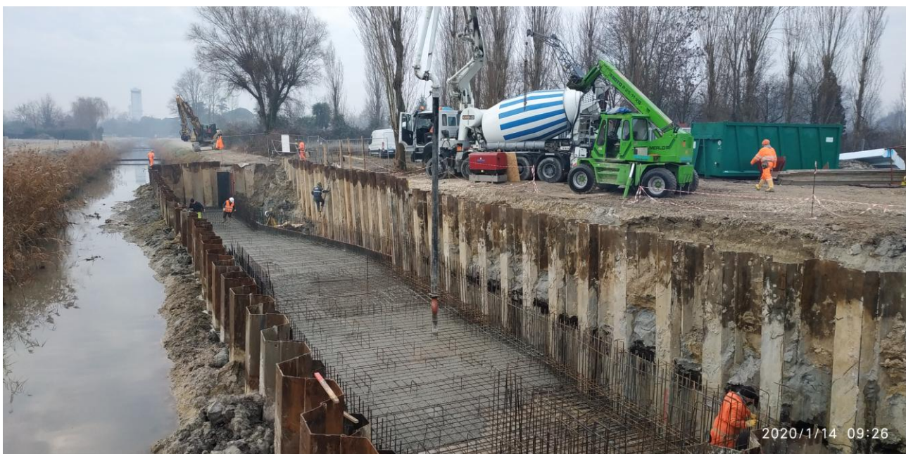
Foto 1 Gettata della base dell'opera di presa presso il collettore Cattal.
