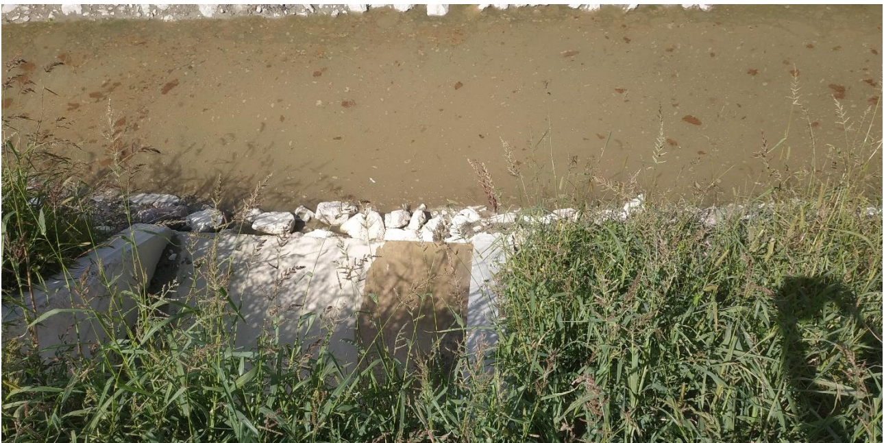
Foto 2 Raccordo tra l'opera di restituzione del bacino e il canale ricevente a nord del bacino stesso.
