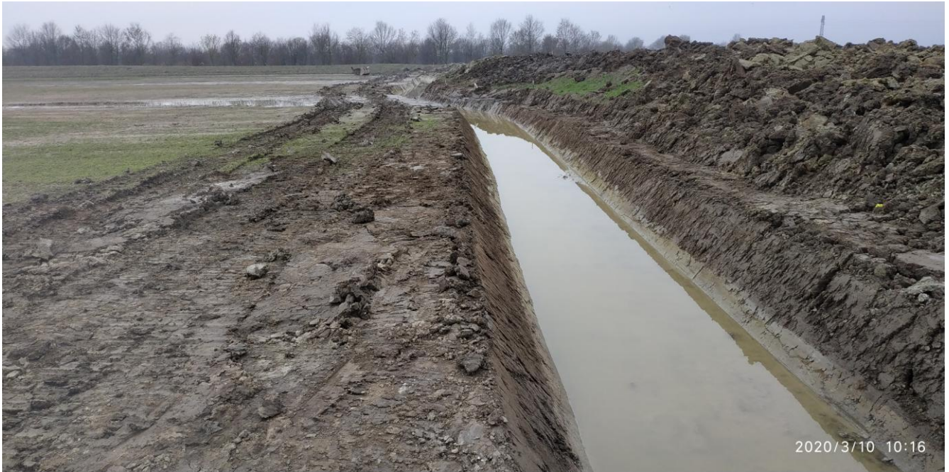
Foto 1 Canale perimetrale collettore delle scoline scavato a piede dell'argine nord del bacino di laminazione.
