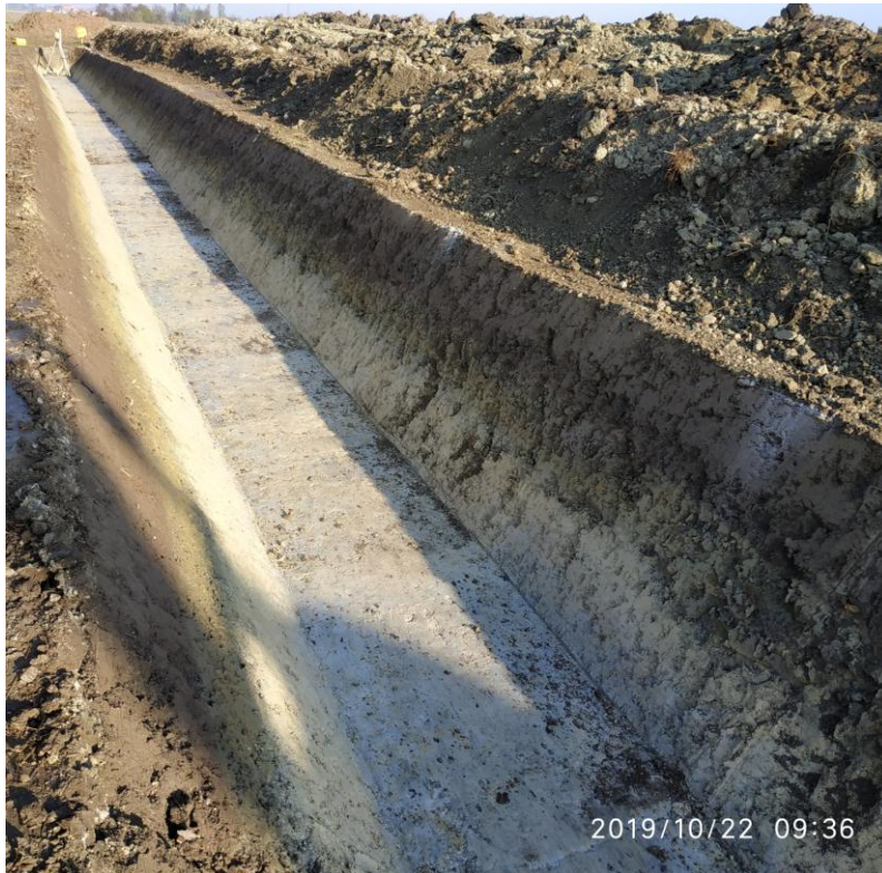
Foto 1 Scavo del canale perimetrale lungo il lato ovest dell'area di espansione.
