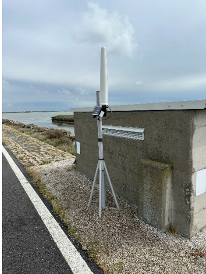
Centralina Mobile 07 (dal 16/04/2023)
