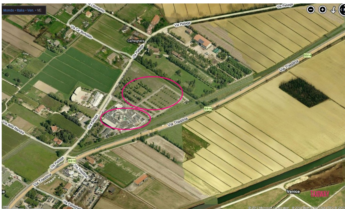
Figura 10 Casinò di Cà Noghera
